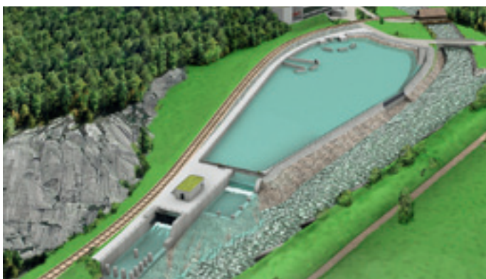
Fig. 4: Modèle d'un petit bassin de compensation [8]. L'image est traversée au premier plan par l'Aar qui s'écoule de haut en bas et de droite à gauche et reçoit la Gadmerwasser à droite du bassin. Un bassin d'environ 50000 m 3 permettrait de ramener le rapport débit d'éclusée/ débit plancher de 8:1 à 5:1.
