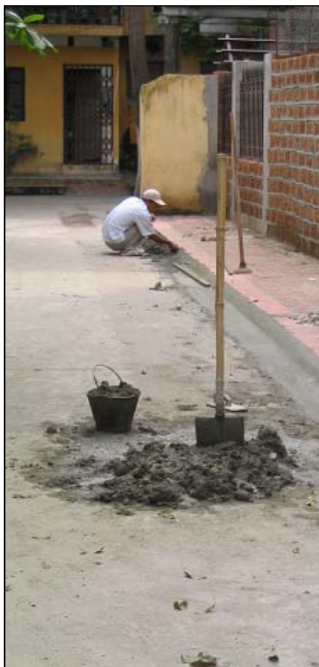
Construction d'un drain par les habitants d'un quartier de Hanoi (Vietnam) un an après la fin d'un projet de développement.
