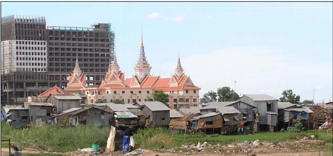
Les rives du fleuve Bassac à Phnom Penh (Cambodge) : l'immeuble en construction (arrière plan) s'élève sur les lieux d'un ancien bidonville incendié en 2000.
