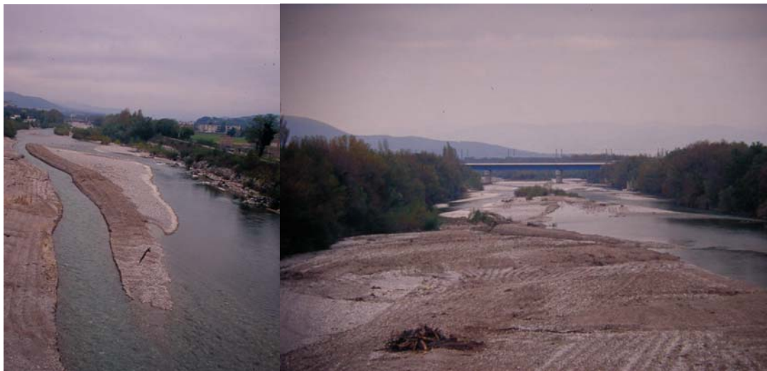
Photo 15 : remobilisation des bancs de galets sur le Drôme : tranchée de redynamisation et griffage de la végétation (cliché N. Landon).
