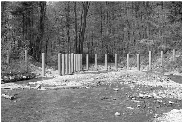
Photo 17 : structure de rétention du bois mort sur la Chämptnerbach en Suisse (cliché G.R. Bezzola).
