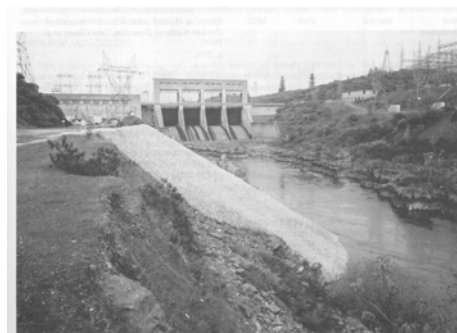
Photo 12 : relargage de la charge grossière à l'aval du Barrage Keswick sur la Sacramento (Kondolf & Matthews, 1993).
