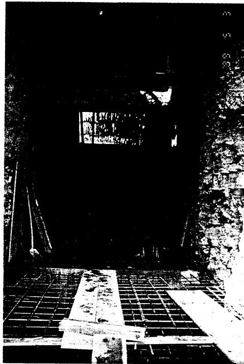
Bild 5: Blick in den Turbinenraum mit eingebauter Bewehrung
