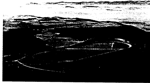
Bild 8: Luftbild vom Oberbecken Hornberg des Pumpspeicherwerkes Wehr
