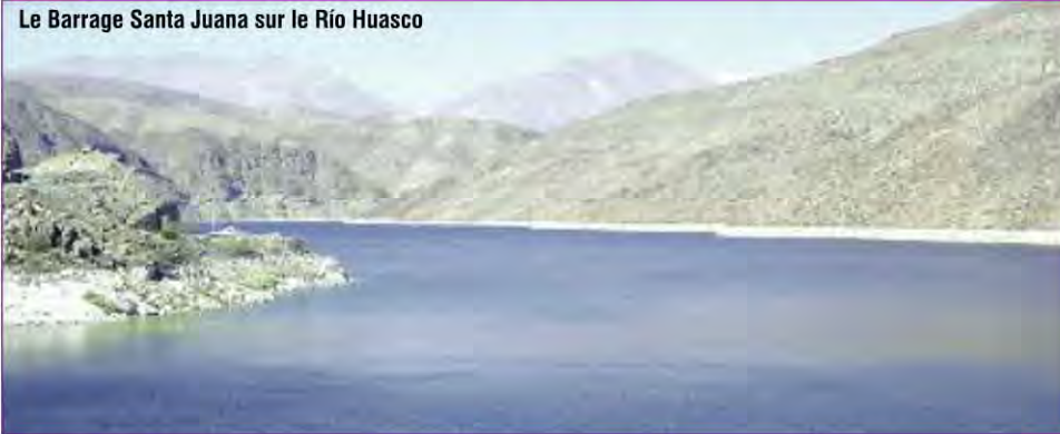
Le Barrage Santa Juana sur le Río Huasco
