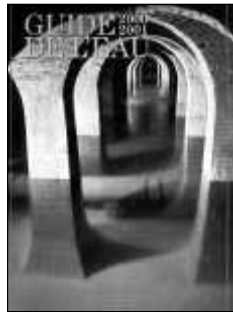
Réservoir d'eau potable situé sous le Parc Mont Souris à Paris.
