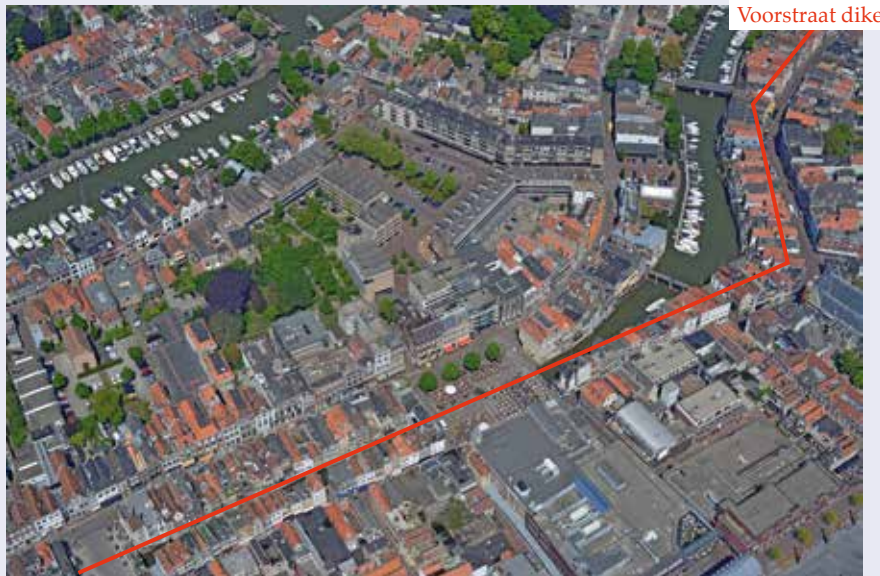
La Voorstraat dike à Dordrecht. Crédit : ville de Dordrecht.
