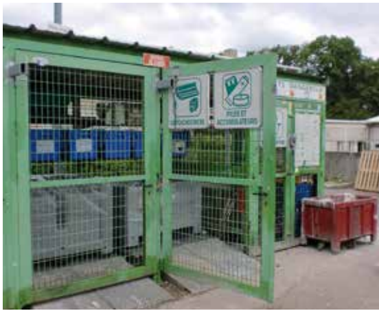
Déchetterie, agglomération d'Orléans (France). Crédit : Communauté d'agglomération Orléans Val de Loire.
