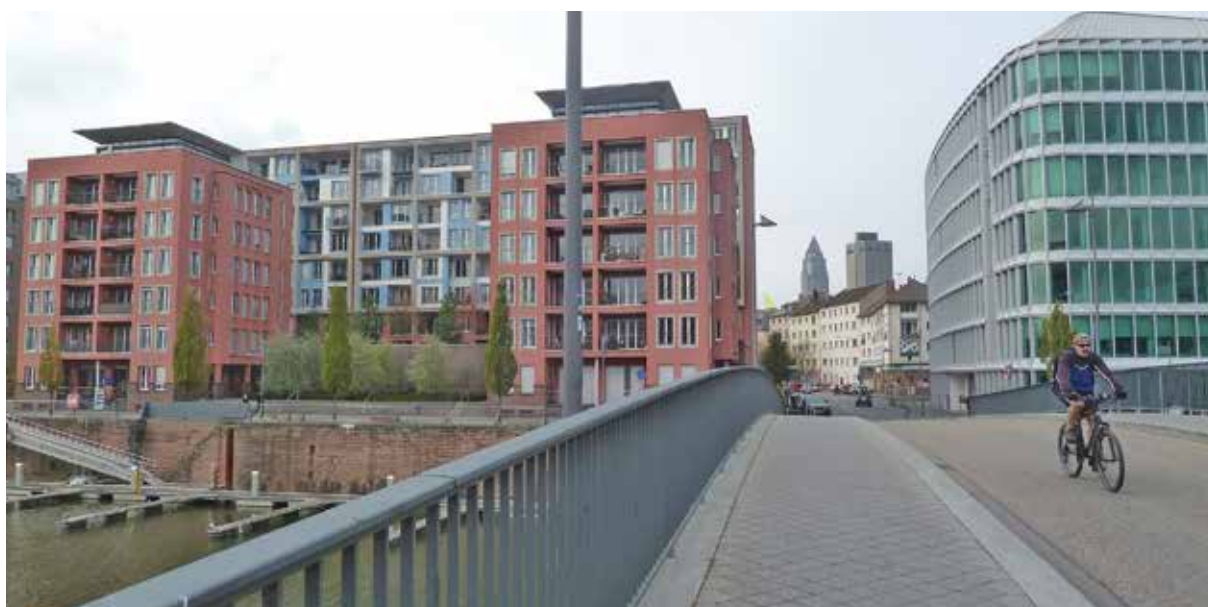
Passerelle permettant de relier le quartier Westhafen au centre-ville de Francfort (Allemagne). Crédit : CEPRI.
