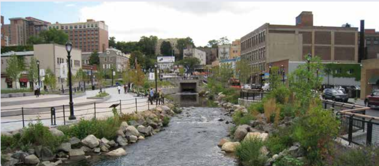
La rivière Saw Mill après sa remise à ciel ouvert à Larkin Plaza, Yonkers. Crédit : Groundwork Hudson Valley.
