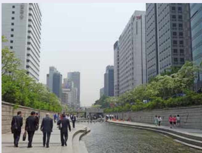
Après destruction de la voie express Cheonggyecheon (2005) et réhabilitation de la rivière. Crédit : Victor Said (IAU Ile-de-France).
