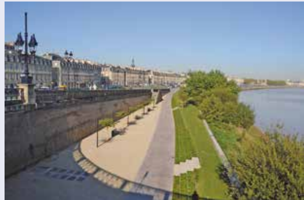
Les quais de la rive gauche de la Garonne à Bordeaux. Crédit : Bordeaux Métropole.
