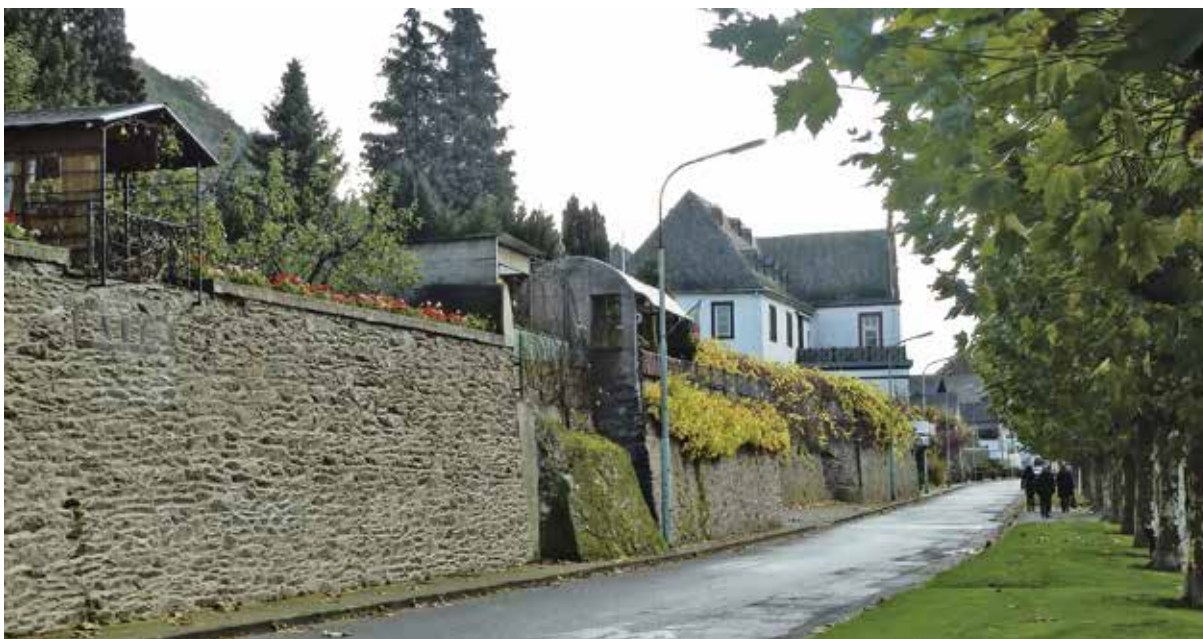
Mur de protection contre les crues du Rhin, à Leutesdorf (Allemagne). Crédit : CEPRI.
