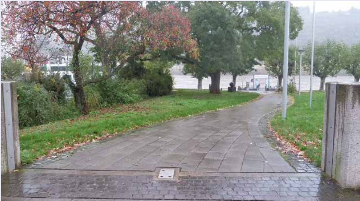
Système de protection à Andernach (Allemagne). Crédit : CEPRI.
