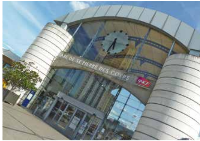
Gare de Saint-Pierre-des-Corps (France). Crédit : CEPRI.
