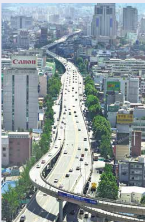
Avant destruction de la voie (2001). Crédit : Seoul Metropolitan Government.
