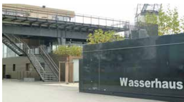
La "maison de l'eau" à Francfort, le long de la rivière Main (Allemagne). Crédit : CEPRI.
