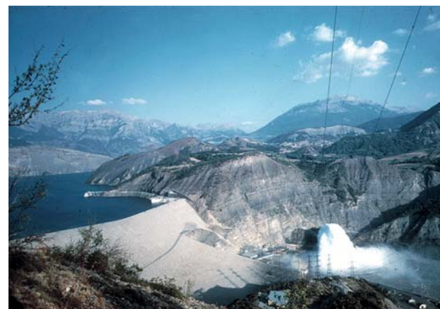
Barrage de Serre-Ponçon sur la Durance, 1962 EDF.
