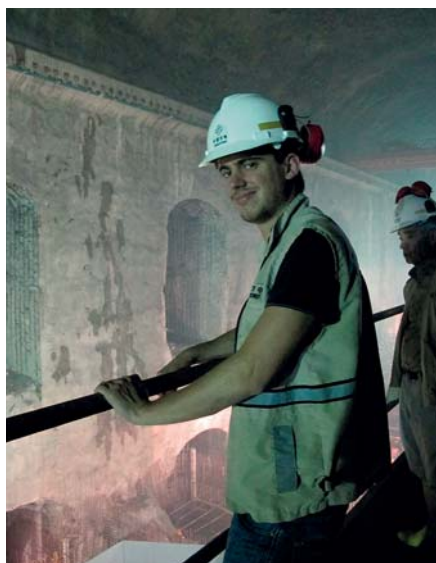
Travaux souterrains à Coca-Codo Sinclair (Equateur).
