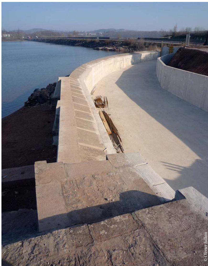
Voies Navigables de France utilise le barrage de Torcy-Neuf (Saône et Loire) pour l'alimentation en eau du Canal du Centre. Construit dans les années 1880, cet ouvrage a été conforté en 2008-2010, sur la base d'un projet approuvé par le CTPBOH, avec notamment construction d'un nouvel évacuateur de crues.
