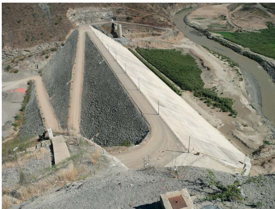
Pérou 2011 - Olmos. Barrage CFRD, 85 m de hauteur, construit en deux étapes.
