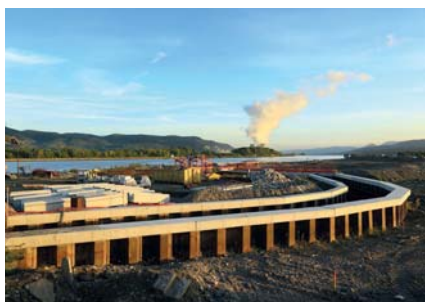
Construction de la petite centrale hydroélectrique et de la passe à poissons à Rochemaure.
