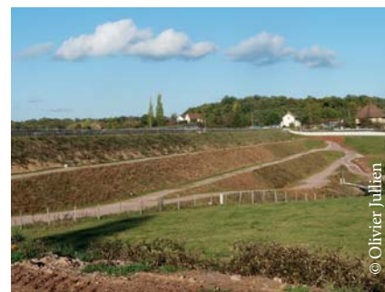
Voies Navigables de France utilise le barrage de Torcy-Neuf (Saône et Loire) pour l'alimentation en eau du Canal du Centre. Construit dans les années 1880, cet ouvrage a été conforté en 2008-2010, sur la base d'un projet approuvé par le CTPBOH, avec notamment construction d'un nouvel évacuateur de crues.
