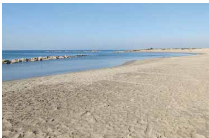
Photo 2 – Une plage de Petite Camargue (Grand Radeau). Les épis (arrière-plan), et l'ancienne digue de fond de plage se sont progressivement enfoncés. L'entretien a été abandonné au regard des enjeux et du coût de protection du site. © F. Sabatier
