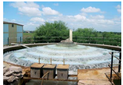
Aération de l'eau brute dans l'usine de traitement
