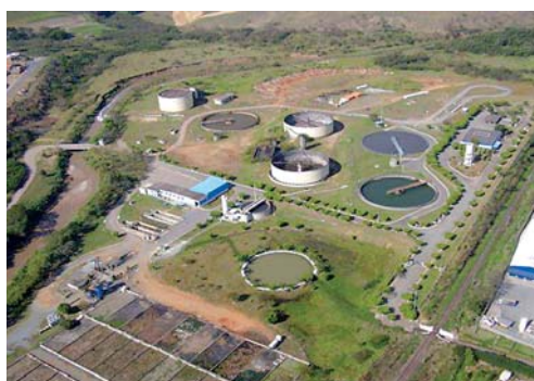
Usine de traitement des eaux usées
