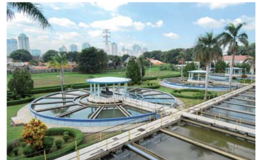
Usine de traitement de l'eau réhabilitée de Pejompongan
