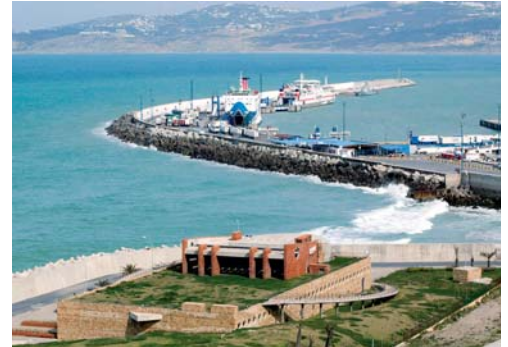
Nouvelle usine de traitement des eaux usées
