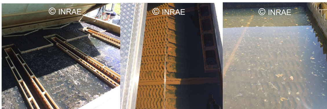
Figure 24 : Exemples de décanteurs lamellaires
